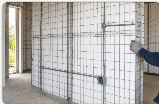
2 2. Colocación de ductos y cajas eléctricas.
