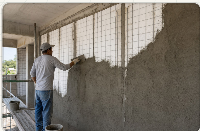
3 3. Primera capa de mortero hasta cubrir malla.
