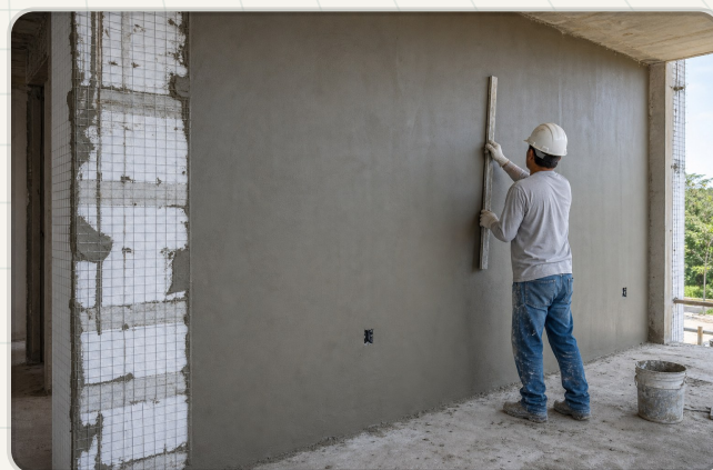
4 4. Segunda capa, nivelado, curado y acabado.
