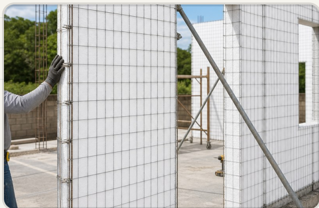
1 1. Preensamble e instalación de paneles completos.
